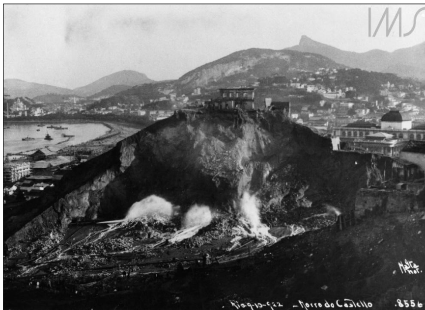
Figura 4 - Demolição do Morro do Castelo, no Rio de Janeiro, 1922
