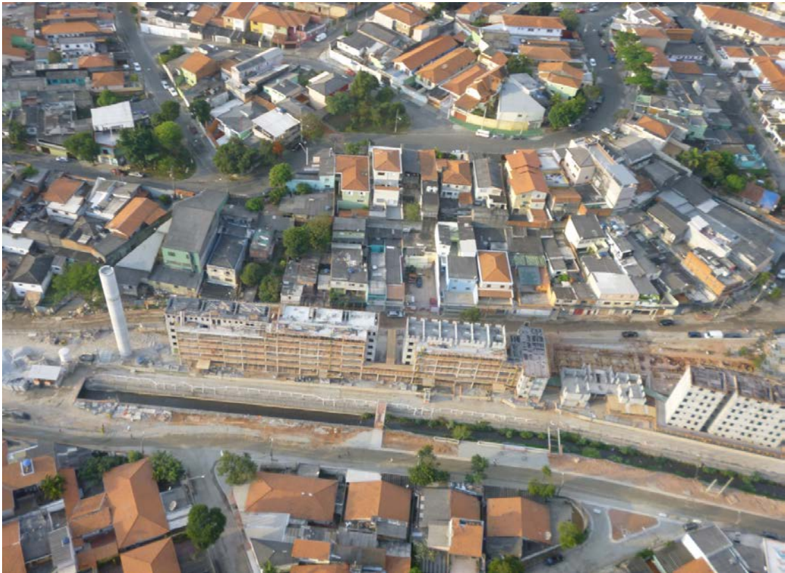
Figura 2. O trecho a jusante do parque linear implantado passa por um processo de urbanização desde 2010; mais de mil unidades habitacionais estão sendo construídas (foto: Solange Silva-Sánchez, 2013).
