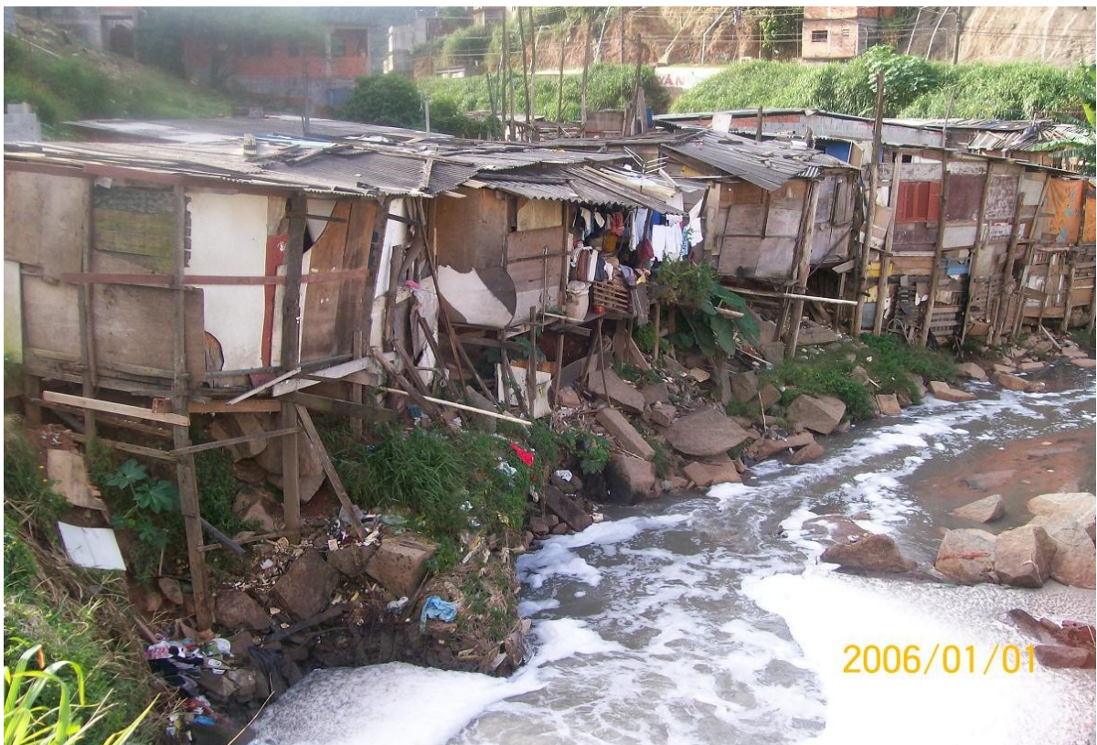
Figura 1. Situação das moradias nas margens do córrego, na região norte do município de São Paulo, configurando importante área de risco. Para a implantação do parque linear nesse local foi necessária a remoção de mais de seiscentas famílias residentes em área de risco (foto: acervo PMSP).
